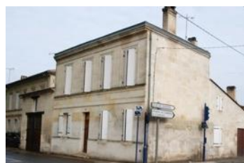
Maison de ville du bourg de Condat
