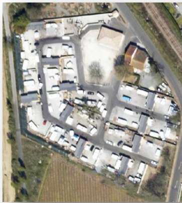
Libourne, aire d'accueil des gens du voyage, chemin du Ruste
