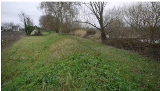
Digue et chemin de halage en bord de fleuve
