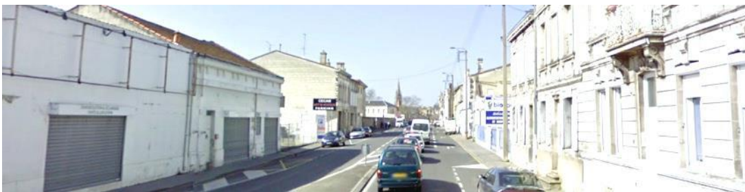
Une arrivée dans le centre, marquée par une large voirie, une qualité bâtie inégale et des panneaux publicitaires (avenue de Verdun)
