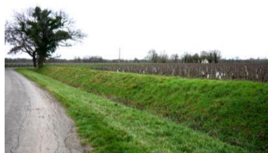
Larges fossés et talus protégeant le vignoble
