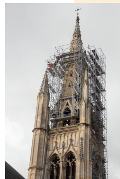
Travaux Eglise Saint-Jean-Baptiste
